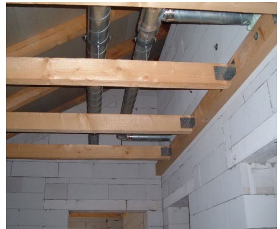
20. Abbildung Luftkanäle innerhalb der thermischen Hülle
