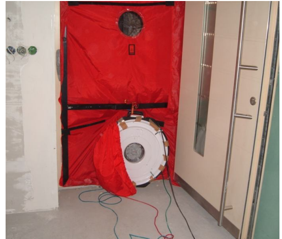
19. Abbildung Blower door Test bei der Eingangstür
