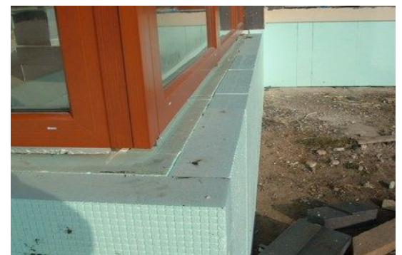
9. Abbildung Wärmedämmung Sockel
