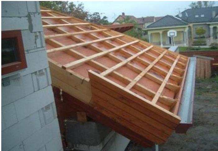
12. Abbildung Aufbau der Dachkonstruktion
