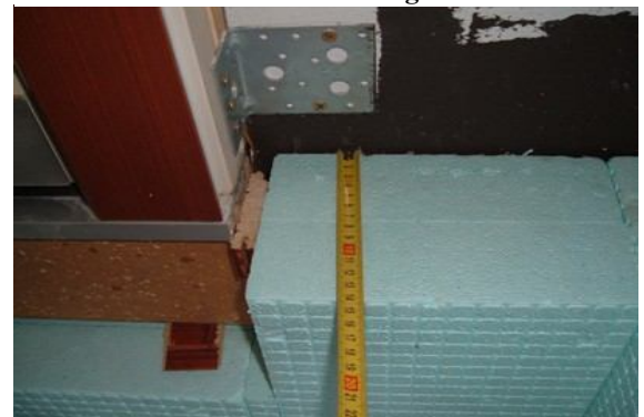
15. Abbildung Verbindung von Terrassentür und Sockel
