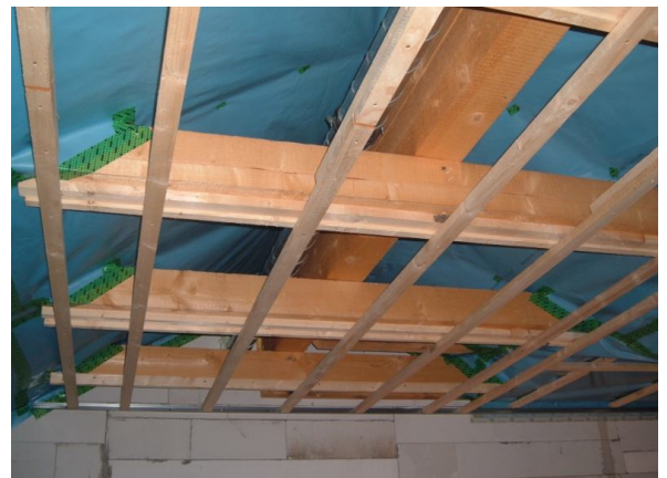
17. Abbildung Luftdämmung unter der Dachebene
