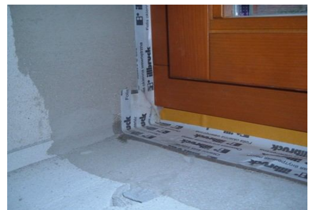
18. Abbildung Luftdämmung um Fenster und Türen
