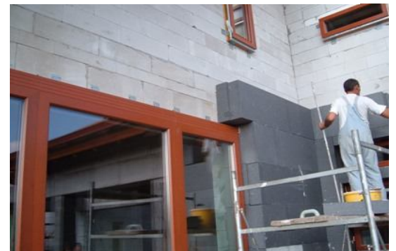
8. Abbildung Platzierung der dässadenwärmedämmung
