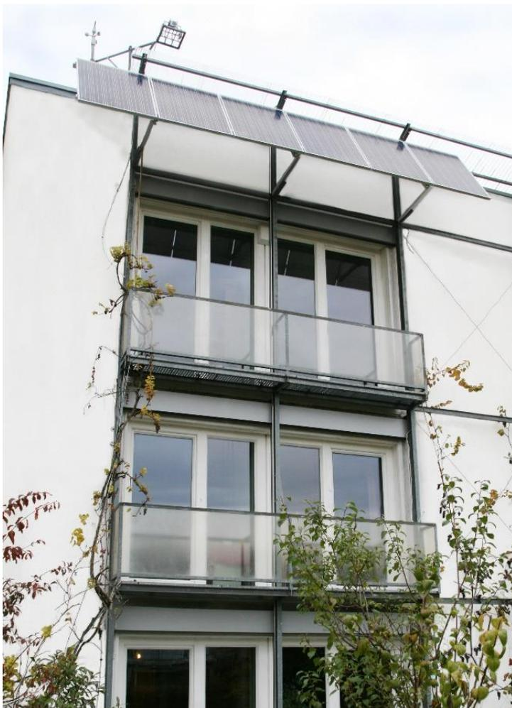
Insgesamt 26 Quadratmeter groß ist die zweiteilige Photovoltaikanlage des Darmstädter Passivhauses. Die Anlage ist an der Terrassenseite sowie auf dem Dach montiert.
