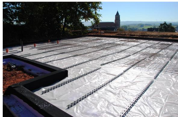
Bild der Dämmung unterhalb der Sohle mit z. T. verlegter Bewehrung
