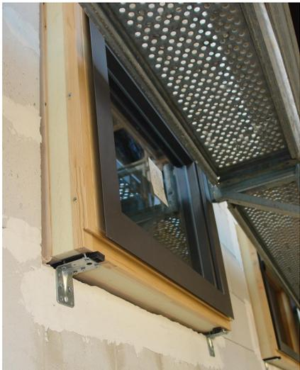
Die Fenster im EG und OG sind zertifizierte Passivhausfenster. Die Fenster sind vor der Kalksandsteinwand montiert. Innen luftdicht angeschlossen um Wärmeströme zu unterbinden. Das WDVS überdämmt den bereits gedämmten Fensterrahmen nochmals.
