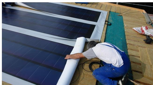
Eine Besonderheit sind die „flexiblen“ in die Dachabdichtung integrierten Fotovoltaikmodule. Diese Module passen sich dem dreidimensional gekrümmten Dach optimal an und wandeln solare Strahlungsenergie direkt in elektrischen Strom um.
