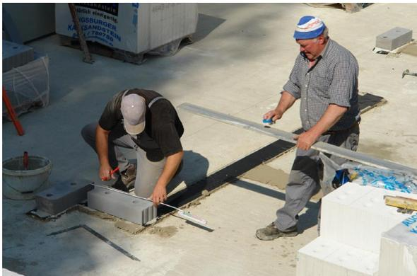
Um die konstruktiv bedingten Wärmebrücken noch geringer zu halten, werden die Kellerinnenwände in der untersten Steinreihe mit KS-ISO-Kimmstein mit guter Materialdämmung vermauert. Die Bodenplatte ist somit unterhalb und oberhalb homogen gedämmt.
