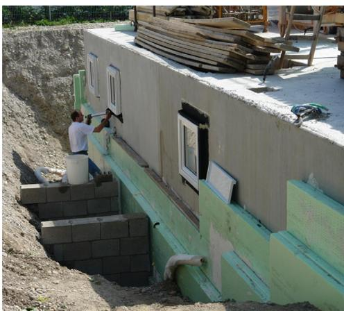
Die Kellerfenster sind zertifizierte Passivhausfenster. Die Fenster sind wie im EG und OG vor der Kellerwand montiert und ausreichend überdämmt.
