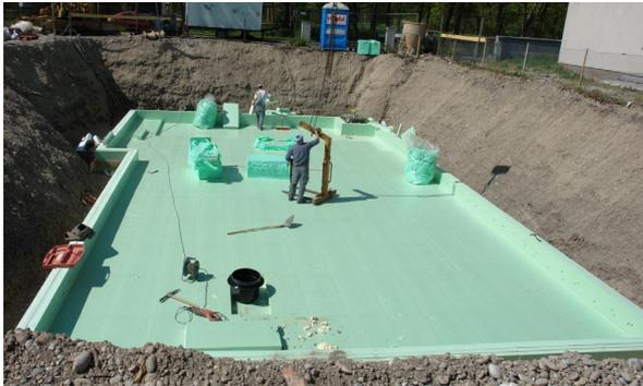
Die Bodenplatte wurde unterseitig zweilagig mit 2 x 120 mm XPS-Dämmung ausgelegt. Die zulässige Ausführung der mehrlagigen Dämmung unterhalb der Bodenplatte wurde vom Hersteller für dieses Bauvorhaben freigegeben. Die statische Belastung der Bodenplatte liegt in allen Bereichen deutlich unter den zulässigen Druckwerten der eingebauten Dämmung. In 50 Jahren wird die Dämmung nur etwa um 3 mm zusammengedrückt.
