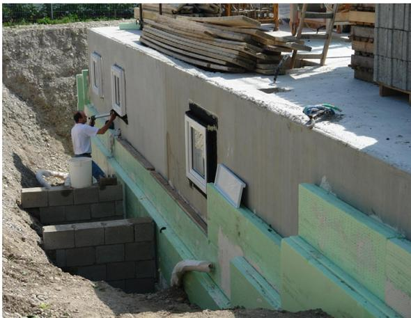
Die Kellerfenster sind zertifizierte Passivhausfenster. Um Wärmeströme zu unterbinden sind die Fenster vor der Kellerwand montiert und luftdicht angeschlossen. Durch die nachträgliche Dämmung der Kellerwand konnten die Kellerfensterrahmen ausreichend überdämmt werden. Alle weiteren Auflager, wie z.B. das Hauseingangspodest sind thermisch von der Fassade entkoppelt.
