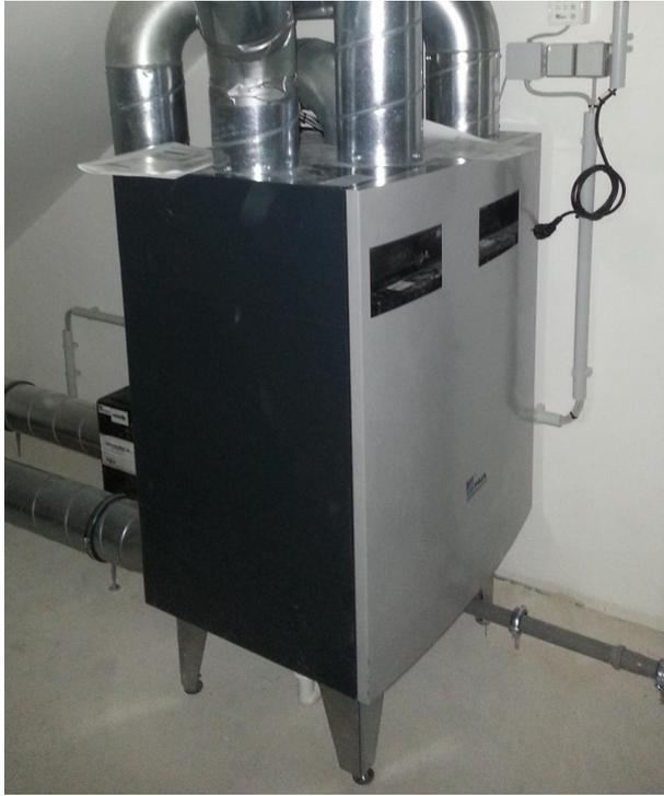
Lüftungsgerät vor Dämmung der Lüftungsleitungen
