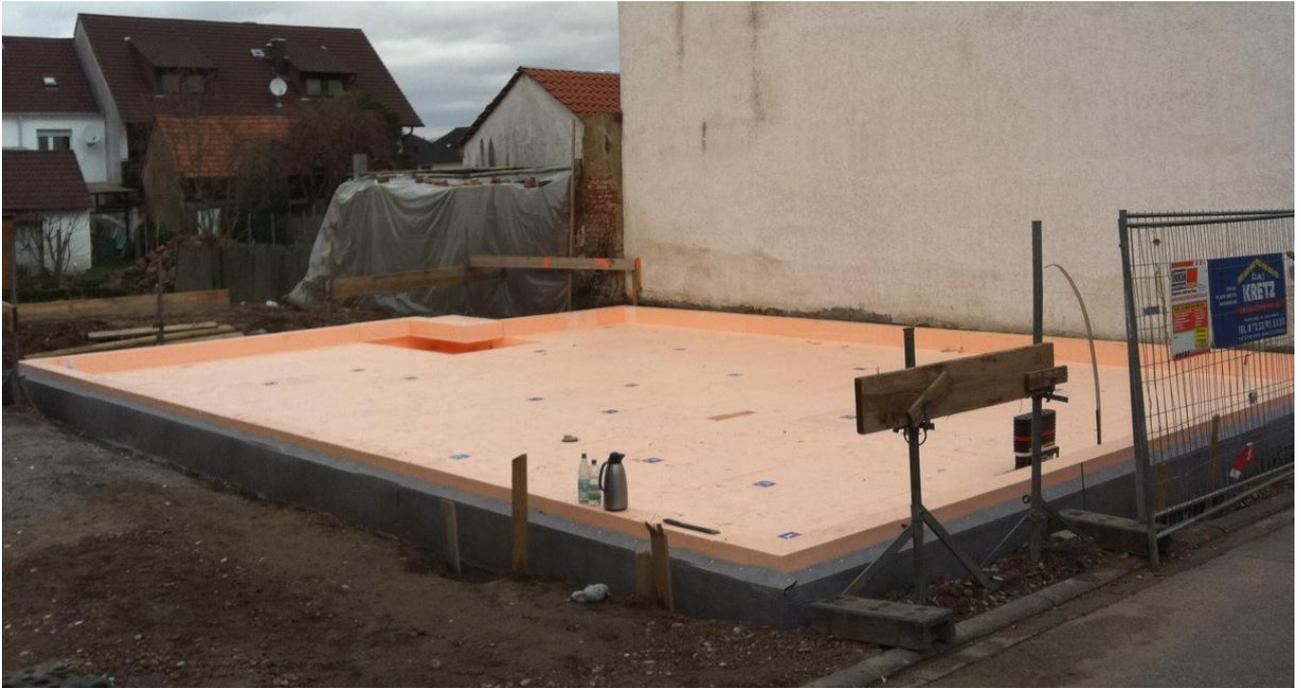
Unterhalb des Erdgeschoßes befindet sich die 25cm dicke STB.-Bodenplatte. Diese ist elastisch auf einer 30cm starken Iso-Quick Dämmung (WLG 038) gelagert, welche zur Nivellierung in ein Splittbett gelegt ist. Oberhalb der Bodenplatte sind 4cm Trittschalldämmung verlegt. Der U-Wert der Bodenplatte beträgt  $0,099\text{W}/(\text{m}^2\text{K})$
