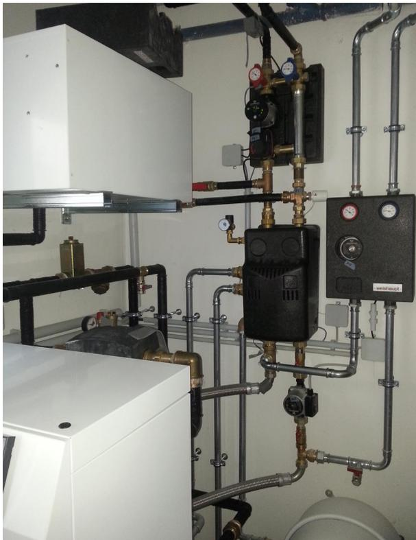
Die Wärmeversorgung erfolgt über eine Sole-Wasser- Wärmepumpe der Firma Weishaupt ( Typ WWP S IB) mit einer Erdwärmesonde als Wärmequelle. Die Wärmeverteilung erfolgt über eine Warmwasser-Fußbodenheizung im Niedertemperaturbereich.
