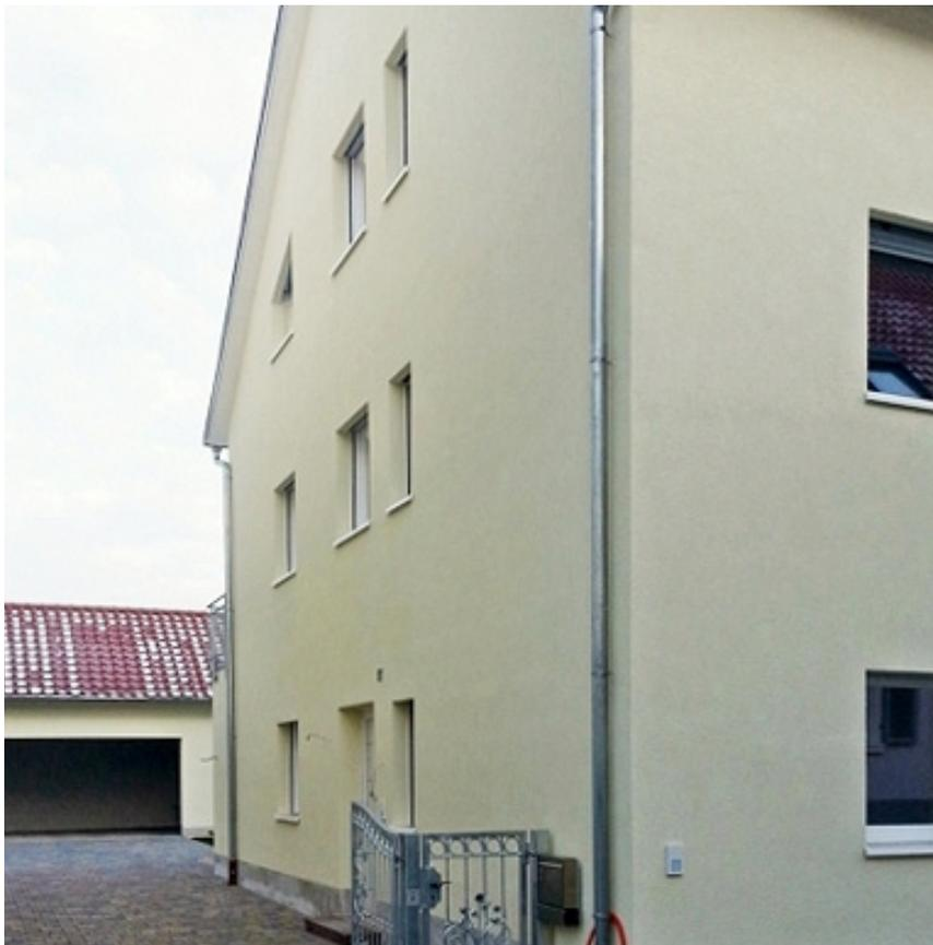
Zur Optimierung des solaren Ertrages wurde das Gebäude maximal nach Westen verschoben und die Westansicht mit vielen Fenstern versehen.
