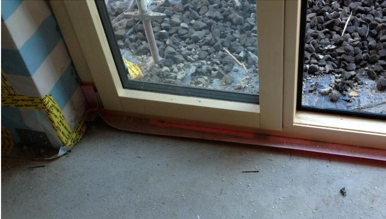
Verglasungselement mit System- Luftdichtheitsanschlußband/
