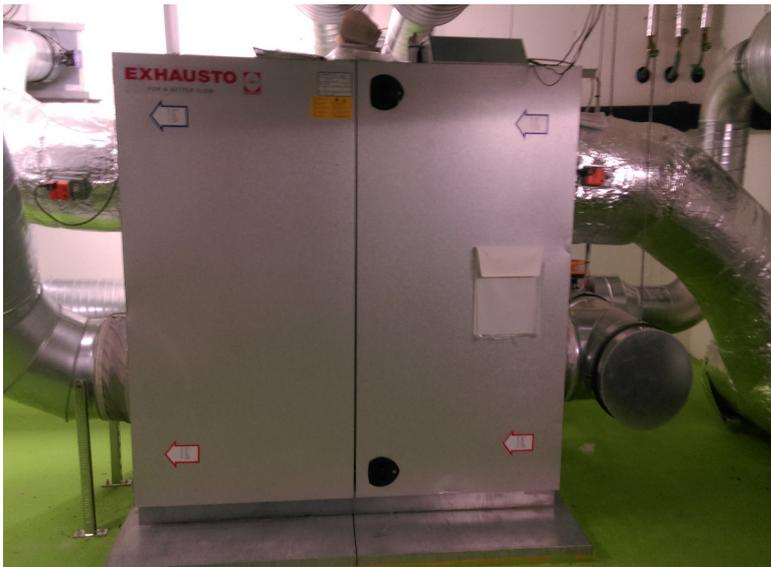
Das eingesetzte Gerät Fa. Exhausto VEX 340 H ist mit einem hocheffizienten Gegenstrom-Luft-Luft-Wärmetauscher (WRG >75 %, Elektroeffizienz 0,63 Wh/m<sup>3</sup>) ausgeführt.
