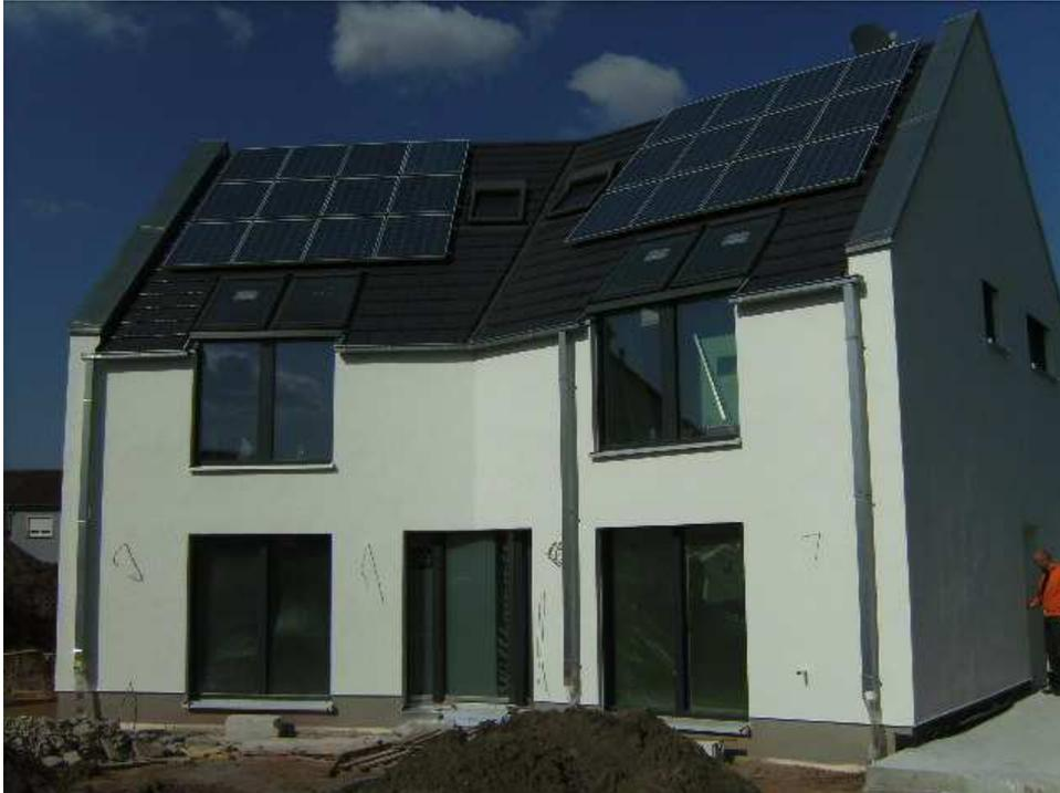
Um den Wärmeverlust der Nordseite ausreichend solare Gewinne von Süden entgegen zu stellen, wurden kniestockhohe Fenster mit Übergang zu großen Dachflächenfenstern geplant.
