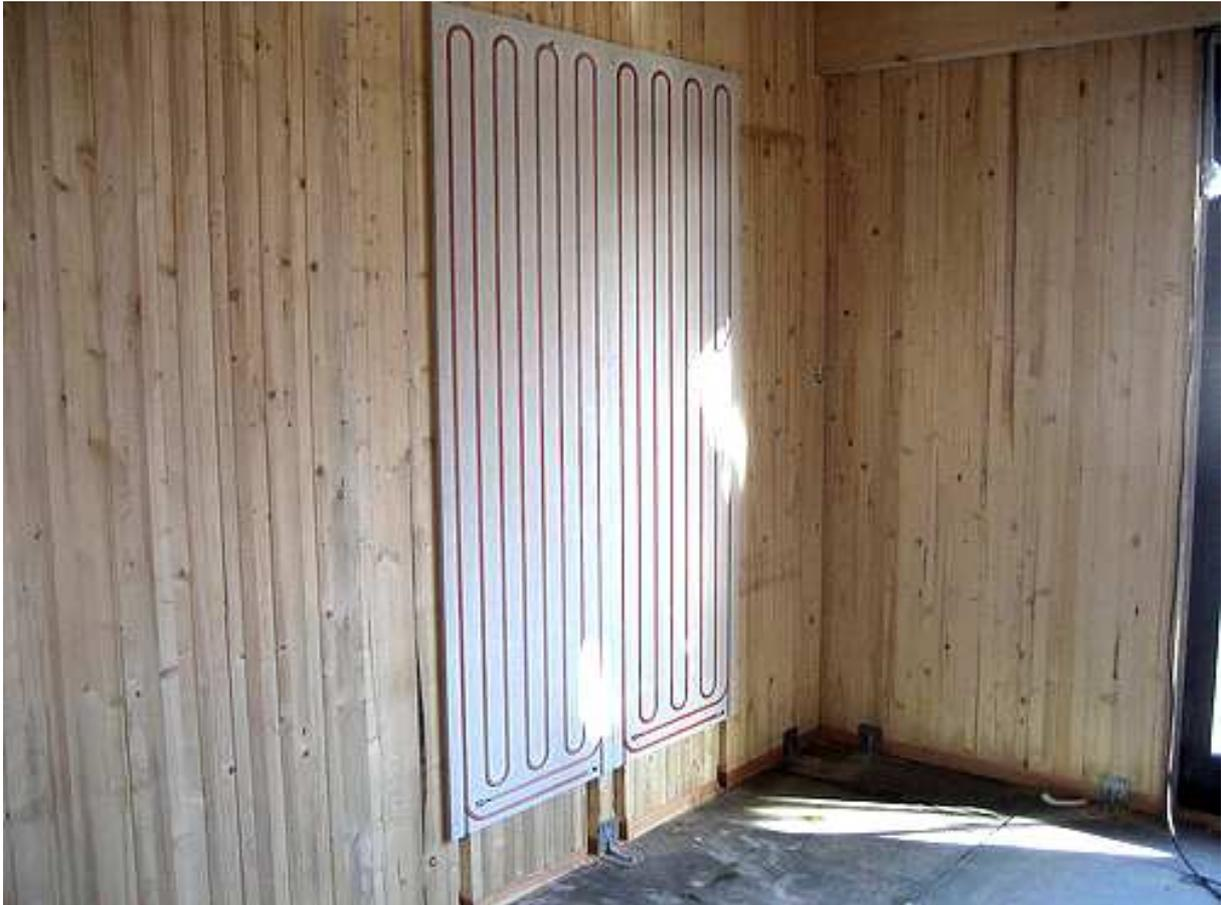
Auch Passivhäuser brauchen ab einer bestimmten Größe zusätzliche wärmeübertragende Flächen, da das Volumen nicht mehr alleine über die Luft beheizt werden kann. Üblicherweise wird dieses mit Fußbodenheizung gelöst. Fußbodenheizungen haben eine niedrigere Vorlauftemperatur als Heizkörper.
