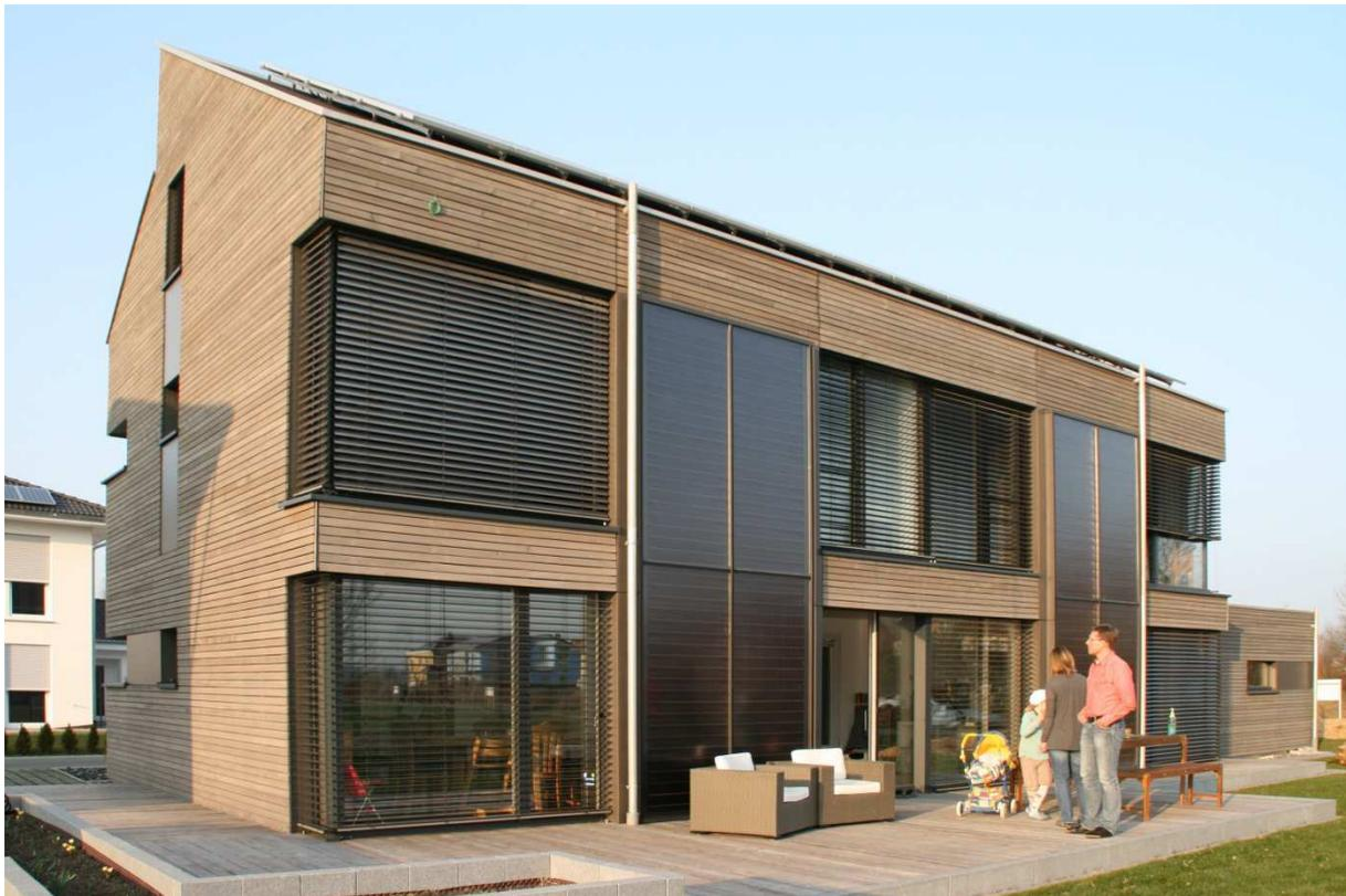
**Passivhaus Christmann in Leutkirch, Ansicht von *Südwesten*:** In der nachbauseitigen Giebelwand gibt es nur wenige kleine West-Fenster. An der Südwestecke und der Südostecke sind in beiden Hauptgeschossen zertifizierte Glasecken ohne Rahmenprofil an der Ecke eingebaut.
