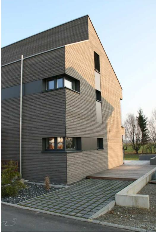
**Aufnahme Passivhaus Christmann in Leutkirch von *Nordwesten*;** auffällig ist die Staffelung der beiden unterschiedlich hohen Pultdächer; das südliche, größere Pultdach ermöglicht eine große PV-Anlage mit einer Leistung von ca. 7 kWpeak.
