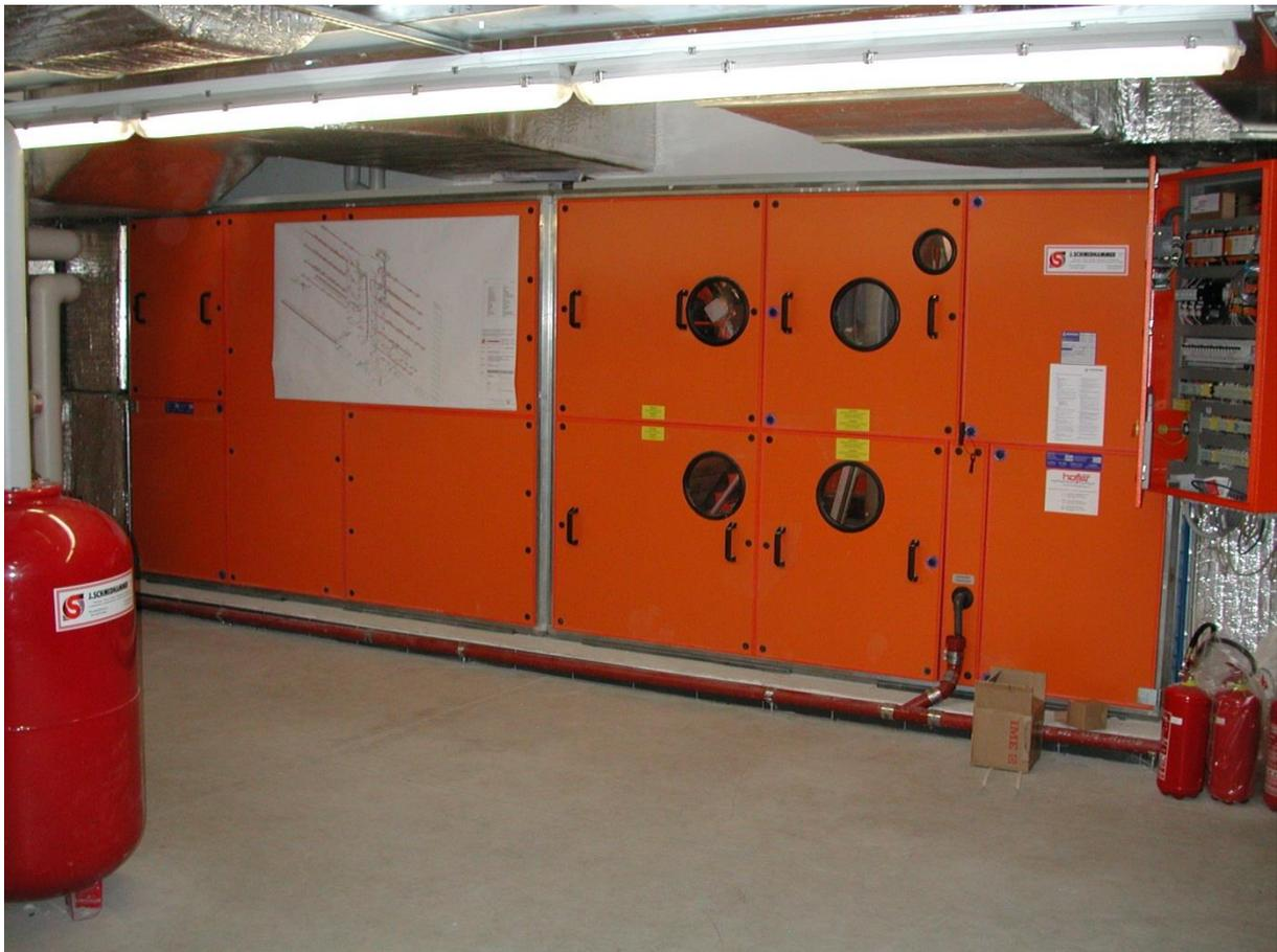
Bei dem im Projekt verwendeten Lüftungsgerät handelt es sich um den Typ **Menerga Resolair**.
