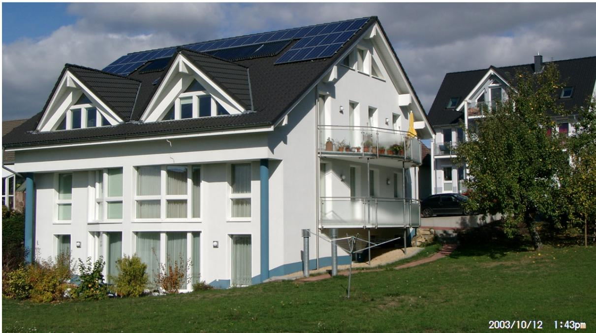
**Passivhaus Carmen, Ansicht von Südosten:** Südwesten mit großzügiger Verglasung und auf der Südostseite die aufgeständerten Balkone mit transparenten Geländerfüllungen. Im Vordergrund sind die 2 Ansaugtürme des Erdwärmetauschers zu erkennen. (Foto: Thomas Weber)
