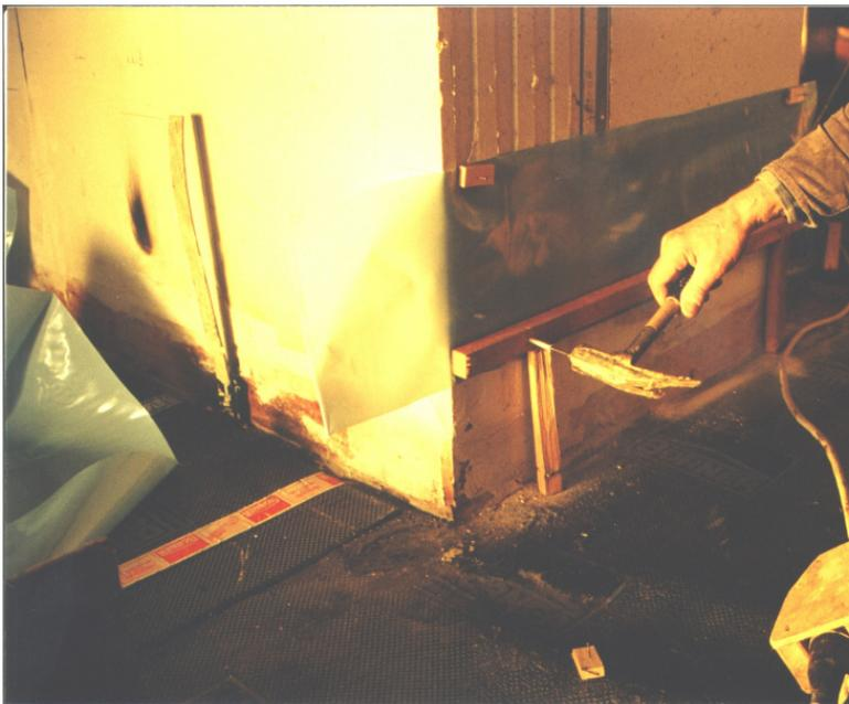
**Kellersohle:** Die Ortbetonsohle ist in sich dicht und wurde mit einer Bitumendichtbahn V60 abgeschweißt. Die Folie zur Abdeckung der Wärmedämmung wurde an alle aufgehenden Wände mit Holzlatten und Kompriband angeschlossen. Der auf dem Bild dargestellte Folienlappen wurde später nach auflegen der Wärmedämmung mit der
