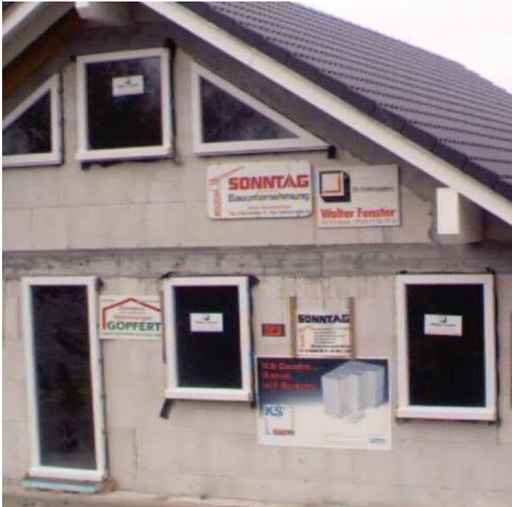
**Fenster:** Die Fensterrahmen aus PVC-Profilen sind luftdicht. Der Putz überdeckt die EPDM-Folien, die die Verbindung zwischen Mauerwerk und Fensterrahmen herstellt. Das Bild zeigt die Fenster, die vor der Mauerwerkswand befestigt und mit schwarzen EPDM-Folien in der Laibung verklebt wurde.
