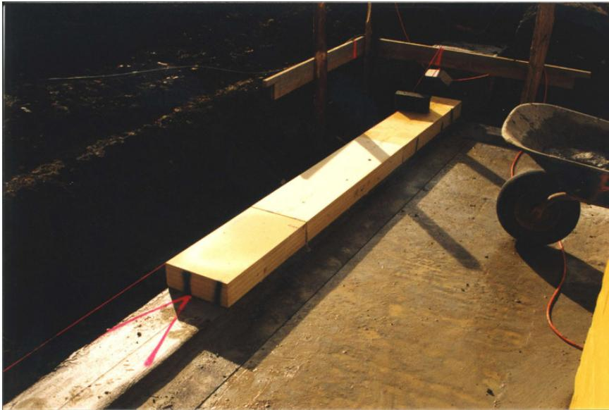
**Vermeidung von Wärmebrücken am Fußpunkt des aufsteigenden Mauerwerks.** Die Wände mit Erdanschüttung werden aus hochwärmedämmendem Porenbeton WLG 100 hergestellt. Der untere Abschluss wurde mit Purenit WLG 070 hergestellt. Im Bereich der Fenster sind Mineralschaumplatten mit einer WLG 045 als druckfester Dämmstoff eingesetzt worden. Die Bodenplatte selbst ist mit einer 25 cm dicken Wärmedämmung
