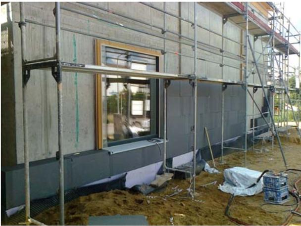
Übergang Perimeterdämmung-WDVS an der Nordseite, Dämmung fugenlos geklebt mit Kreuzfugen, komplette Überdämmung des Fensterstocks.
