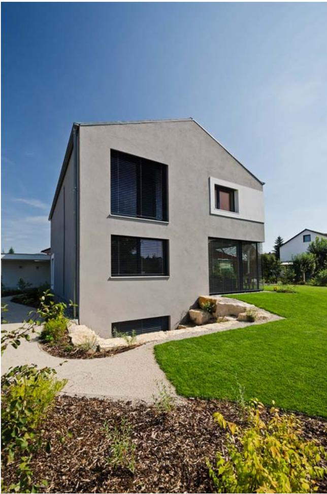
**Westseite** mit bereits angelegter Böschung zum bewohnbaren Teil des Kellers (Wohnraumfenster wie in den Obergeschoßen). Die Verschattung der Fenster wird durch Jalousien bewerkstelligt, die in der Dämmebene liegen und vollständig hinter der Fassadenputzfläche verschwinden. Gesteuert werden diese über ein Bus-System.
