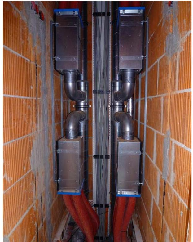
Die Lüftungsleitungen werden in die Decken (Ortbeton) nach Plan eingelegt. Die Installation im Haus in vertikaler Richtung aus dem Technikraum im KG erfolgt über den durchgehenden Versorgungsschacht. Im Bild rechts die "aufgeräumte" Installation, trotz geringer Abmessungen im Schacht konnte alles passend untergebracht werden und bleibt jederzeit durch Schranktüren von den Fluren aus zugänglich.
