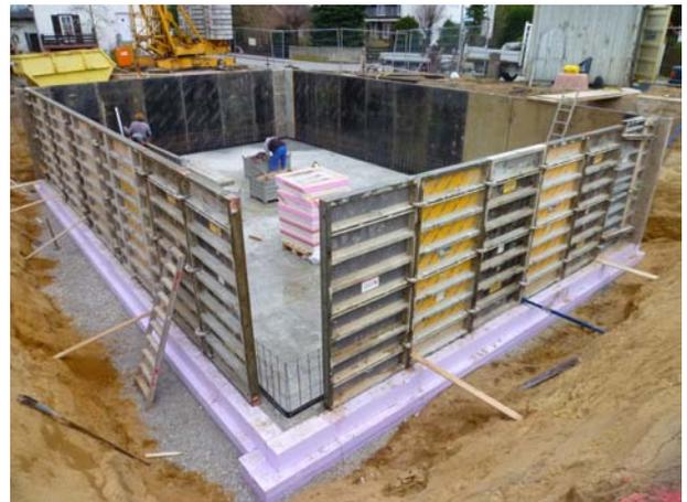
Kelleraußenwände und Außenwände der Obergeschoße sind in Stahlbeton in unterschiedlichen Dicken nach statischen Erfordernissen ausgeführt, der Ausgleich in der Wandstärke erfolgt über unterschiedliche Dämmstärken.
