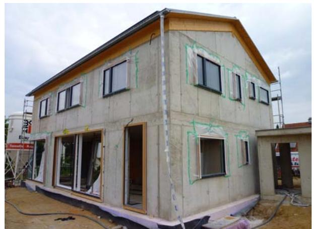
Zum Schutz des später überdämmten, aber im Moment noch offenen Fensterstocks (nach außen hin aus Holzfaserdämmung) wurde eine Abdeckfolie angebracht.
