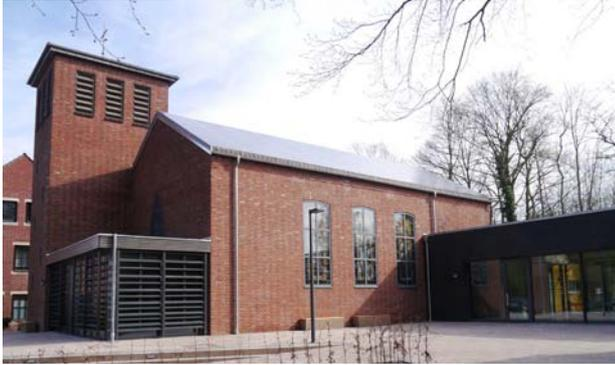
Zunächst sollte in einer ersten Maßnahme die Kirche energetisch saniert werden und in einem zweiten Bauabschnitt das Pfarrhaus. Ziel war jeweils eine Zertifizierung nach dem Zertifizierungs-System „EnerPHit“ (Passivhaus im Bestand).
