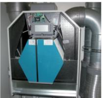
Komfortlüftung mit Wärmeübertrager
