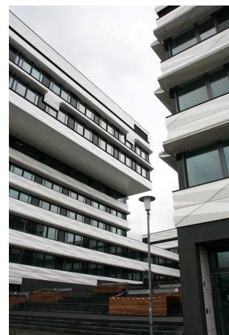
Bürogebäude in der Heidelberger Bahnstadt. Foto: PHI
