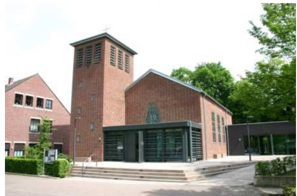
Eine mit Passivhaus-Komponenten sanierte Kirche in Heinsberg (EnerPHit). RoA / Foto: Passivhaus Institut
