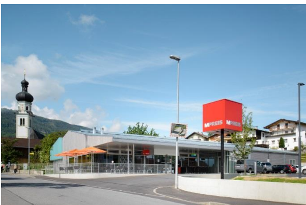
Der neue Supermarkt im Passivhaus-Standard in Natters bei Innsbruck. Foto: MPREIS
