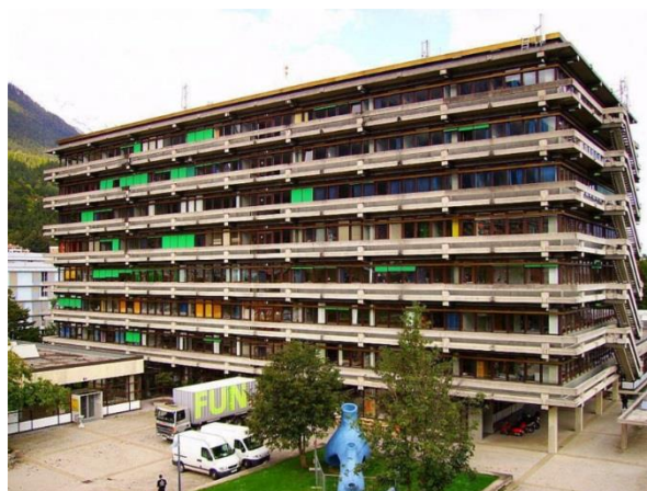
Aufnahme des Universitätsgebäudes in Innsbruck vor Beginn der Sanierung. Fotos: Passivhaus Institut
