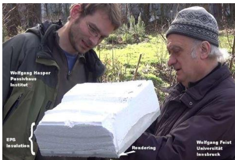
Intensive Tests belegen die Dauerhaftigkeit: Die Dämmung des ersten Passivhauses ist nach 25 Jahren noch vollständig intakt. Im Video ist auch zu sehen, wie die Experten die Probe entnehmen. Foto: PHI
