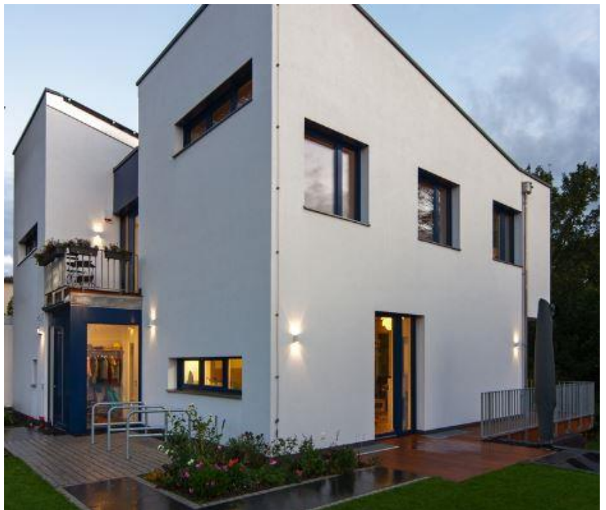
Der Neubau in Berlin aus anderer Perspektive. Regenwasser wird gesammelt, um Waschmaschine sowie Toilettenspülung zu bedienen. © Andrea Kroth
