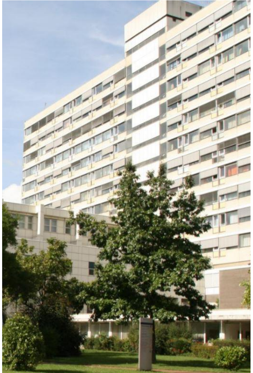
Das Bestandsgebäude des Klinikums Frankfurt Höchst aus den sechziger Jahren. Mit dem Neubau im Passivhaus-Standard sollen unter anderem die Betriebskosten des Krankenhauses drastisch gesenkt werden.
