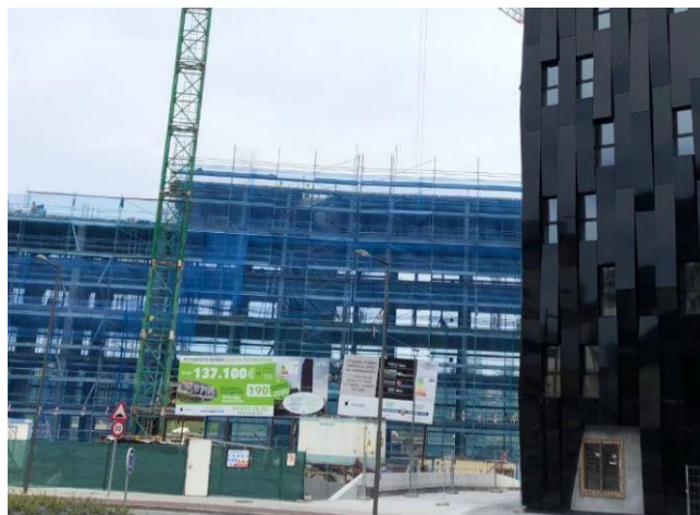
Direkt neben Bolueta in Bilbao entsteht ein weiteres Passivhaus-Hochhaus mit 190 Wohnungen. © VArquitectos
