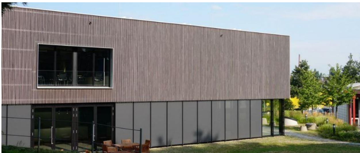
Das Verwaltungsgebäude der Deutschen Bundesstiftung Umwelt (DBU) in Osnabrück ist ebenfalls bei den Tagen der offenen Tür im Passivhaus für einen Besuch inklusive Führung geöffnet, ID 1428. © DBU
