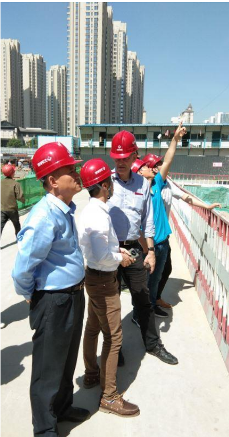
Kollegen des Passivhaus Instituts besuchen in der Stadt Taiyuan eine Passivhaus-Baustelle. Die Tagung im Oktober steht unter dem Motto „Passivhaus weltweit“ und stellt Projekte rund um den Globus vor. © PHI
