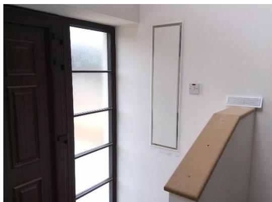
die die Wärme der Abluft nutzt, um die frische Zuluft vorzuwärmen. Dadurch wird ganz nebenbei Energie gespart.
