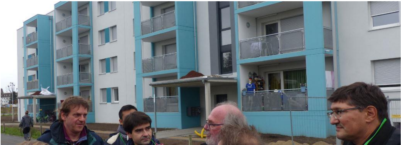
Sozialer Wohnungsbau im Passivhaus-Standard: Beim PassivhausSozialPlus in Darmstadt zielen die Nebenkosten auf zwei Euro pro Quadratmeter, inklusive Budget für Strom und Warmwasser, Grauwassernutzung sowie Internet. Das bundesweite Modellprojekt stand beim Arbeitskreis kostengünstige Passivhäuser sowie bei einer anschließenden Exkursion zu den Tagen der offenen Tür im Fokus. © Passivhaus Institut
