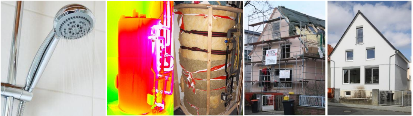
Drei Beispiele für Anpassungen, um sich rasch, zeitnah und mittelfristig von fossiler Energie unabhängiger zu machen (v.l.): Eine wassersparende Duschbrause, nachträgliche Dämmung des Warmwasserspeichers (hier mit recyceltem Material) sowie die hoch energetische Sanierung des Gebäudes. © Passivhaus Institut
