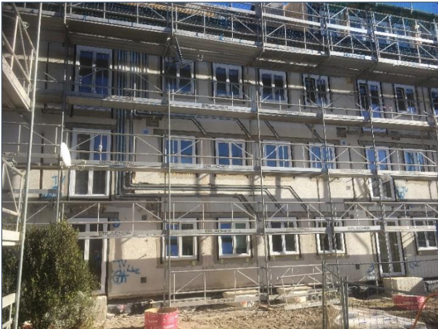
Bei dieser Sanierung sind die Zu- und Abluftkanäle für die Lüftungsanlage in die Fassade integriert. Damit reduzierten sich die Bauarbeiten in den Wohnungen. Die Folge: Mehr Mieterinnen und Mieter stimmten dieser energetischen Sanierung in Innsbruck zu. © Passivhaus Institut
