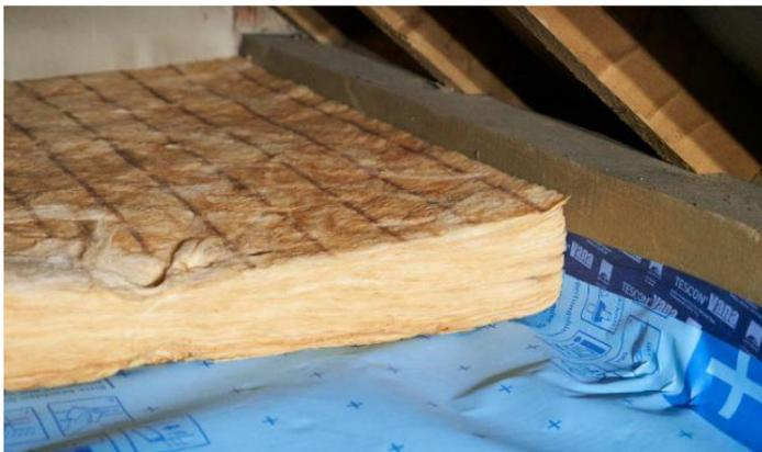
Luftdichtheit ist auch bei der Dämmung der obersten Geschossdecke wichtig. Das Passivhaus Institut zeigt beim 5. Passivhaus-Abend in diesem Jahr, worauf es ankommt, wenn diese Dämmung in Eigenarbeit realisiert wird. © Passivhaus Institut
