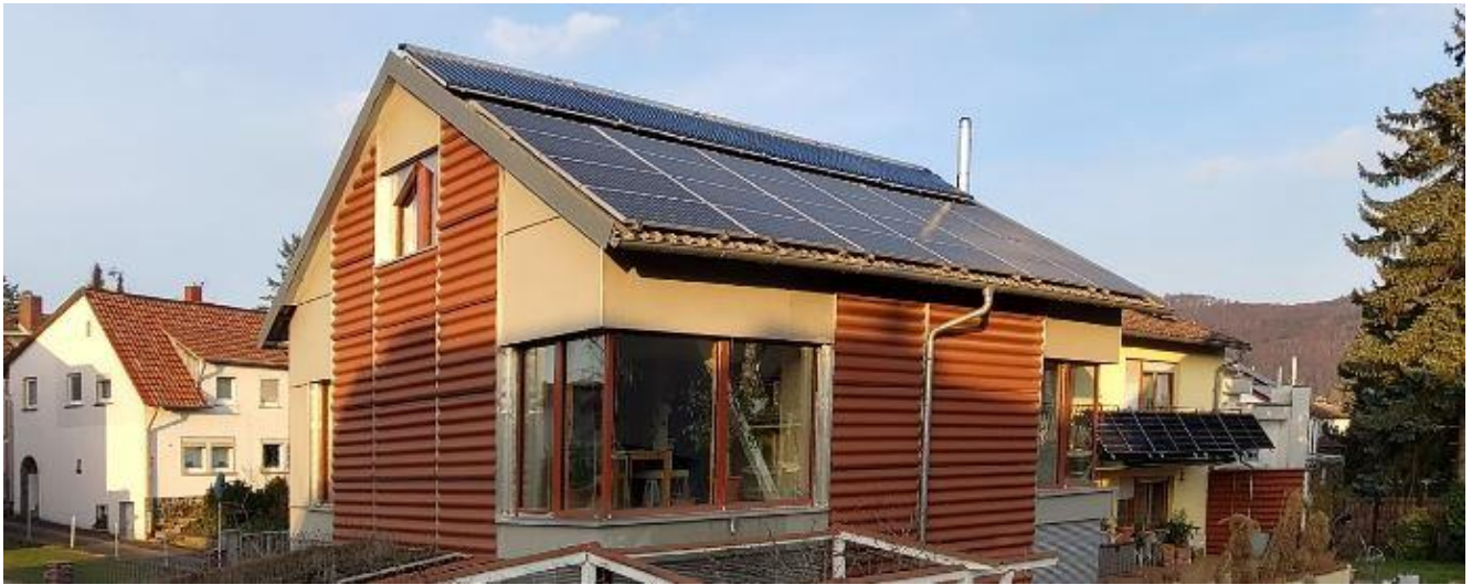
Hier in Südhessen wird die Energie der Sonne gleich dreifach genutzt: Am vorderen Haus sind Anlagen für Photovoltaik und Solarthermie installiert, am hinteren Gebäude ein Balkonkraftwerk (rechts). © Stadt Riedstadt
