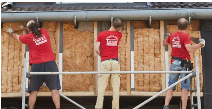
Etwas anspruchsvoller, jedoch ebenfalls in Eigenarbeit realisierbar: Außendämmung am Gebäude. Hier wurde im Rahmen von #EnergieEffizienzJETZT eine Holzträger-Konstruktion mit Mineralwolle ausgefüllt. © Passivhaus Institut
