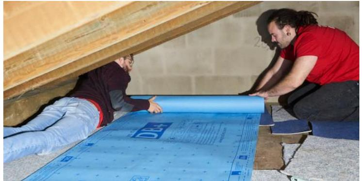
Mit einer gut gedämmten obersten Geschosdecke sinkt der Energieverbrauch und in den Wohnräumen wird es meist deutlich gemütlicher. Diese Arbeit kann auch in Eigenarbeit realisiert werden, wie das Passivhaus Institut bei der Aktion #EnergieEffizienzJETZT demonstriert. © Passivhaus Institut
