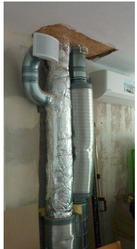
Die Rohre für die Lüftungsanlage mit Wärmerückgewinnung verlaufen überwiegend am früheren Kaminschacht und werden noch verkleidet. © PHI
