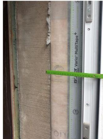
**Bild oben:** Beim Darmstädter Einfamilienhaus Baujahr 1928 ist der neue Wandaufbau mit der Dämmung um rund 30 Zentimeter dicker geworden. Fenster und Haustür sind entsprechend nach außen gerückt. Ein guter Wärmeschutz sorgt im Winter für angenehm warme Räume und schützt im Sommer vor Hitze. Zudem sinkt der Energiebedarf deutlich.
