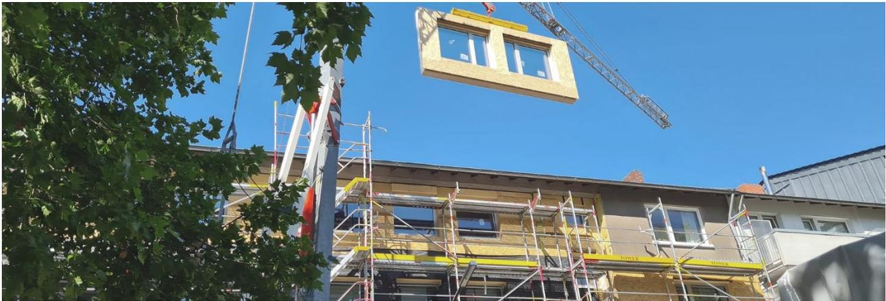
Energetische Sanierung mit Passivhaus-Komponenten in Köln. Um die Bauarbeiten möglichst kurz zu halten, wurden seriell vorgefertigte, hoch wärmegeämmte Fassaden- und Dachelemente verwendet. © Zeller Kölmel Architekten
