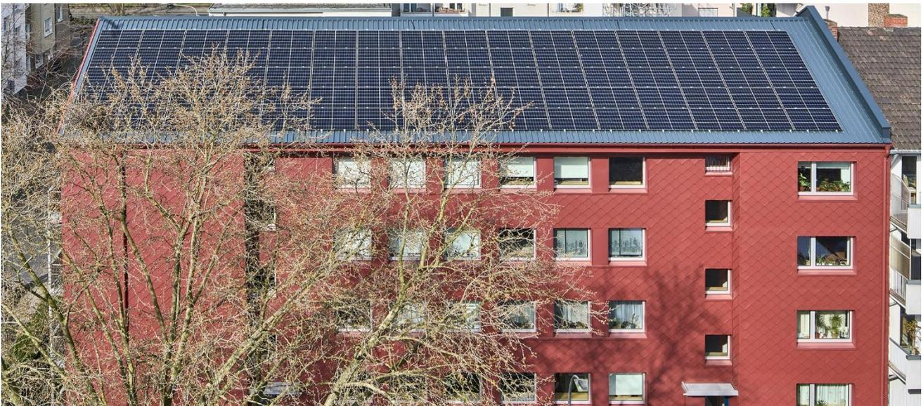
Nach der energetischen Sanierung: Aus dem ungedämmten Kölner Altbau wurde ein hoch energieeffizientes Gebäude mit großflächiger PV-Anlage auf dem Dach, das sogar den Standard Passivhaus Plus erreicht. Die Wärmeversorgung erfolgt über Wärmepumpe. Die Mietparteien haben aufgrund des deutlich niedrigeren Heizwärmebedarfs auch deutlich geringere Energiekosten. Der bessere Wohnkomfort kommt als großes Plus hinzu. **ID 7540** © dena | Jens Willebrand
