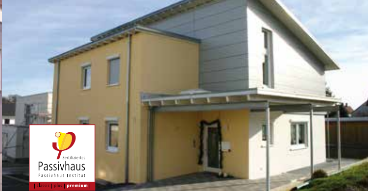
Zwei-Familienhaus in Ochsenhausen | Foto © Keck Architekten GmbH
