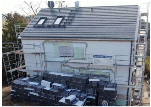
Modernisierung eines **Gebäudes** aus den 1960er-Jahren zum Standard **EnerPHit Plus**. Mit der Photovoltaikanlage auf dem Dach lädt die Baufamilie aus Darmstadt auch das eigene Elektroauto. © G. Bednarek
